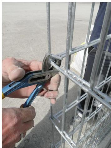
Après l'assemblage des deux panneaux les tirants internes doivent être positionnés en suivant en quantité et en position ce qui est indiqué dans le plan de montage (différent pour chaque type de cage).
