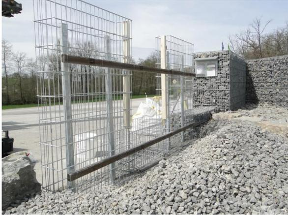
On procède maintenant à l'alignement et au raidissement des panneaux. Pour y parvenir il est recommandé d'utiliser des poutres en bois à placer horizontales pour renforcer la structure. Cela sert d'aide au remplissage empêchant à l'ensemble de bouger de sa position prédéterminée.
